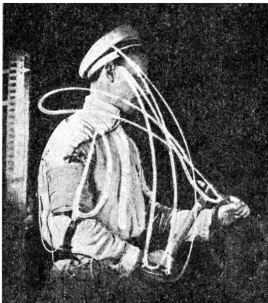
Рис. 70. Циклограмма рубки зубилом, снятая без вертящегося затвора. Вертикальный удар (см. лекцию 10). Снято автором в ЦИТ'е.
