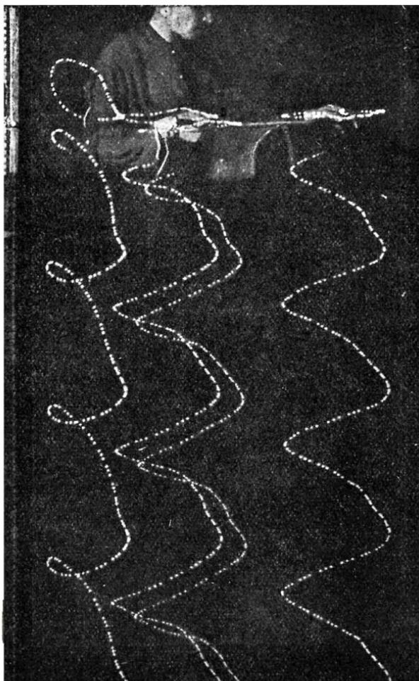
Рис. 73. Циклограмма опилки, снятая с помощью камеры со скользящей кассетой. Слева направо следы: 1) правого локтя, 2) правого запястья, 3) правого указат. пальца, 4) левого большого пальца. Снято автором в ЦИТ'е.
